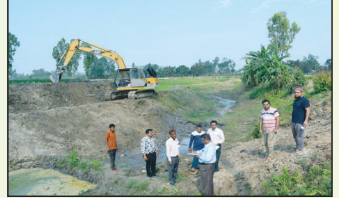
প্রকল্পের আওতায় ২০১৯-২০ অর্থ-বছরে রংপুর জেলার পীরগঞ্জ উপজেলায় আখিরা মরা খাল পুনঃখনন কাজ পরিদর্শনের চিত্র।
