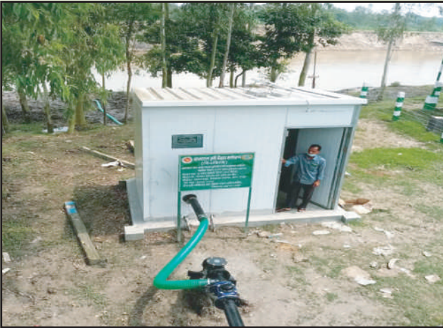
বদরগঞ্জ উপজেলার লোহানীপাড়া ইউনিয়নের কাঁচাবাড়ী মৌজায় স্থাপিত ডুয়েল পাম্পিং সিস্টেমে নির্মিত ০.৫-কিউসেক সোলার স্কীম।
